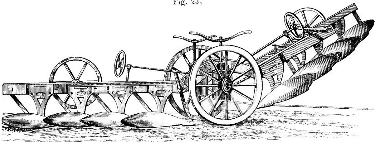
Besondere Vorrichtungen bei der Maschinerie dienen dazu, dass Locomobile und Anker in dem Maasse vorgerückt werden, als Streifen gepflügt werden.
