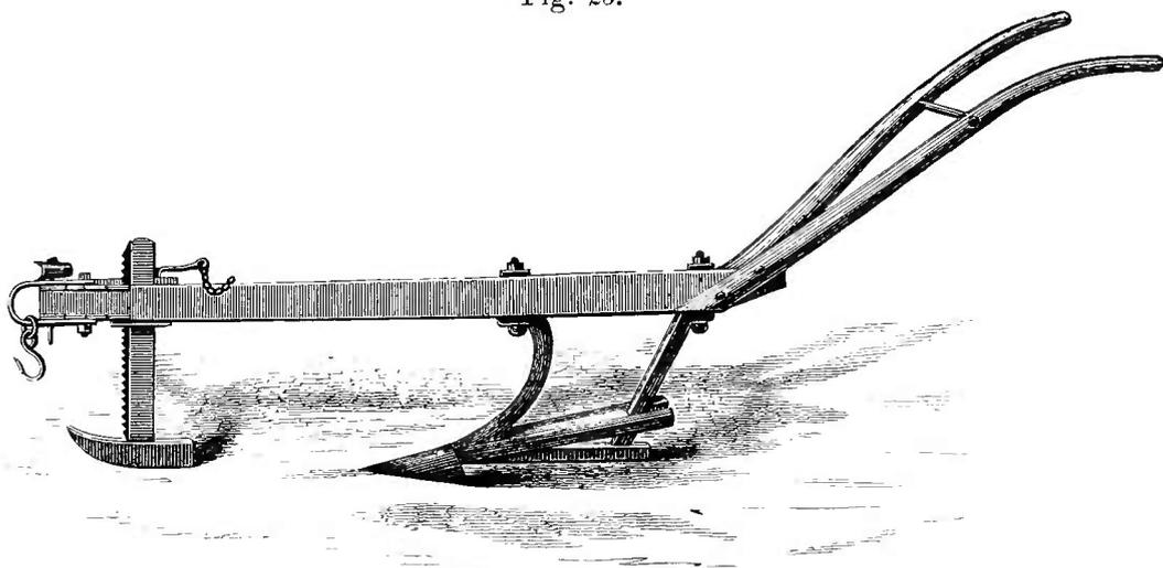
Krauss ersichtlich. Ein von Lord Beauclerk construirter Wühler soll die bessere Bodenkrümlung bewirken, indem eine mit schraubenförmigen Messern besetzte Welle hinter dem Schaar angebracht ist, welche beim Fortgehen des Pfluges im Boden um ihre eigene Achse sich dreht.
