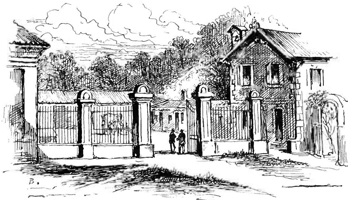
Lahouringue. ( Bâtiments d'exploitation.)
