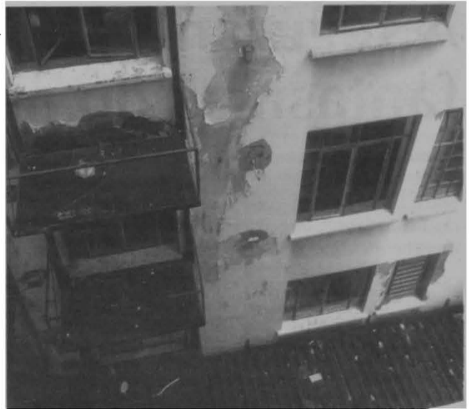
Vista interna do Anexo IV - novo prédio da Biblioteca 2
